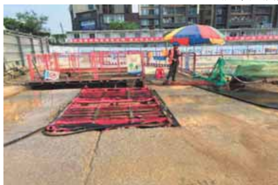
项目东侧洗车池及配套沉砂池
