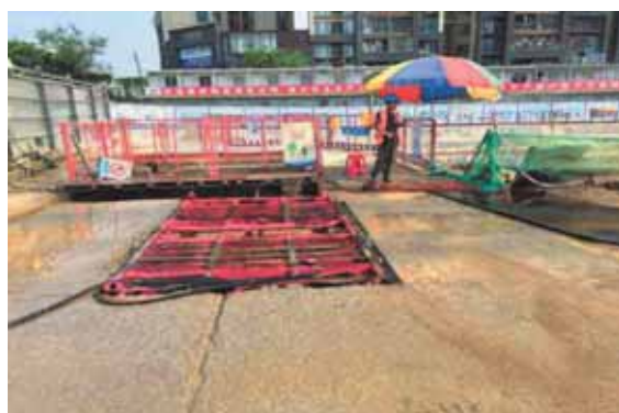
项目东侧洗车池及配套沉砂池
