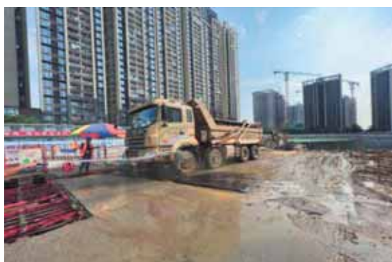
项目东侧洗车池及配套沉砂池
