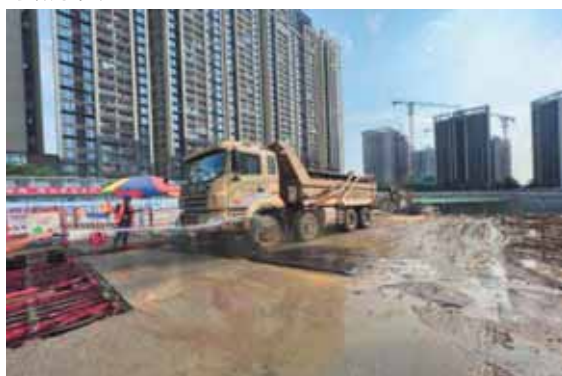
项目东侧洗车池及配套沉砂池
