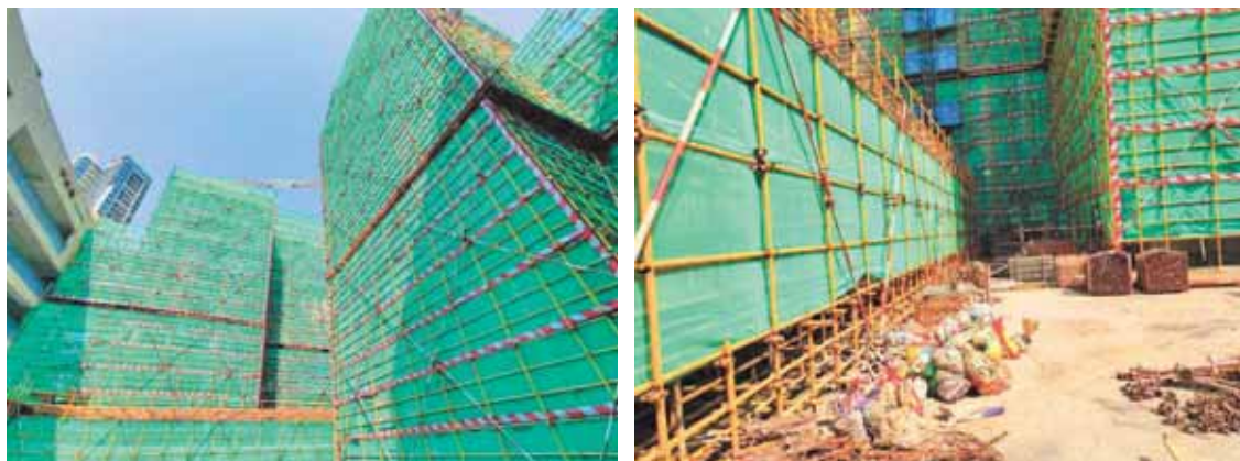
地上建筑阶段
