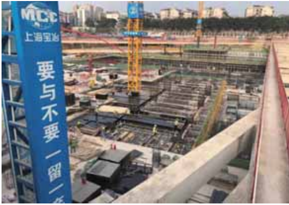
北侧基坑施工现状
