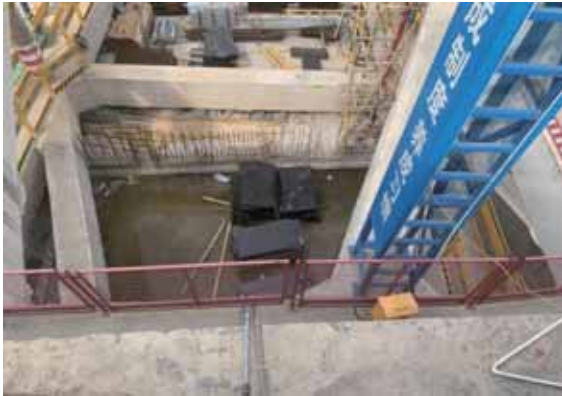
基坑蓄水抽排设施
