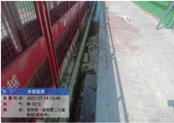
基坑顶南侧排水沟
