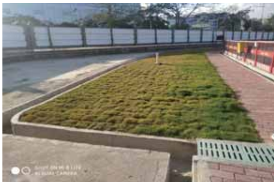
基坑顶西侧排水沟及临时绿化
