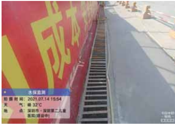
基坑顶北侧排水沟
