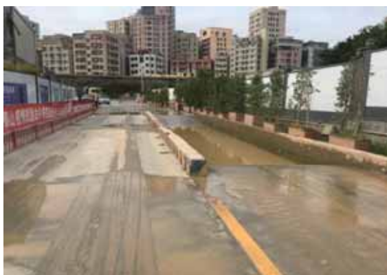
东南侧施工次出入口洗车池
