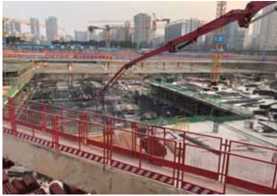
北侧基坑施工现状
