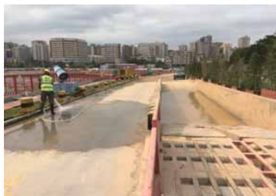
东南侧施工次出入口洗车池
