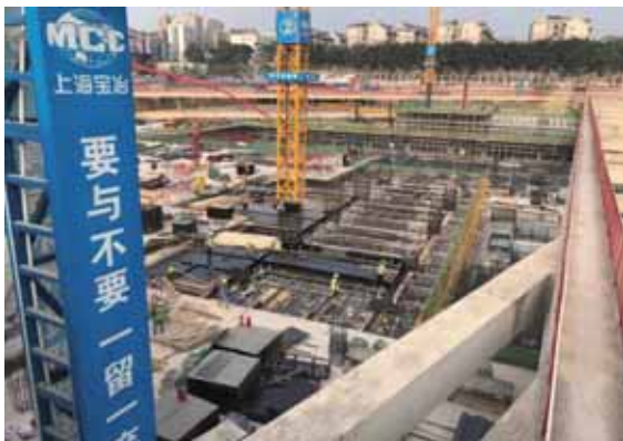
北侧基坑施工现状
