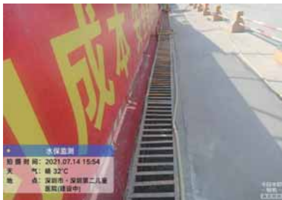
基坑顶北侧排水沟
