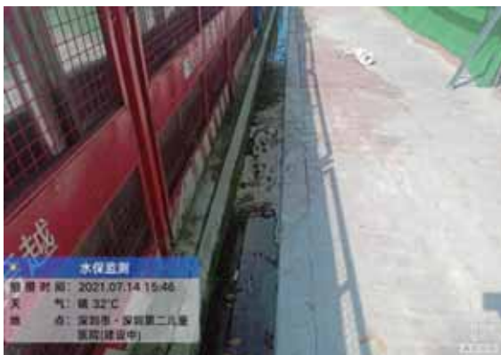
基坑顶南侧排水沟
