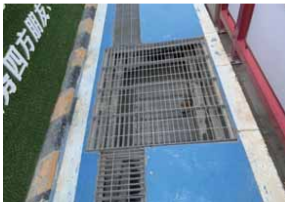
项目内沉砂池
