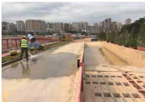
东南侧施工次出入口洗车池
