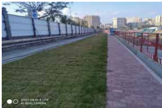
基坑顶西侧排水沟及临时绿化
