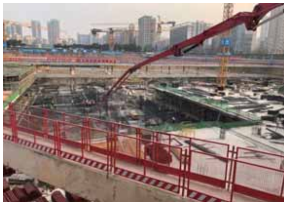
北侧基坑施工现状
